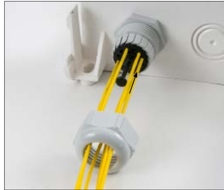
Einführung FTTH Kabel Insertion câble FTTH FTTH Cable Insertion
